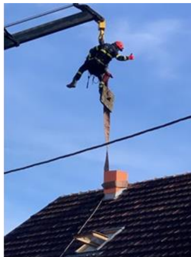
Detalj skidanja dimnjaka
