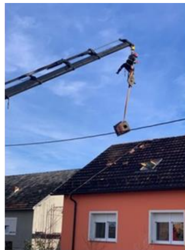
Detalj skidanja dimnjaka
