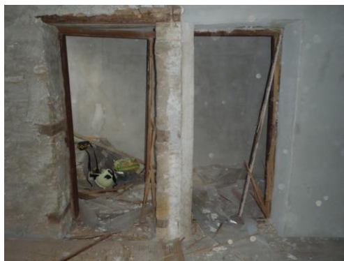
Izbijanje štokova vrata uslijed udara groma
