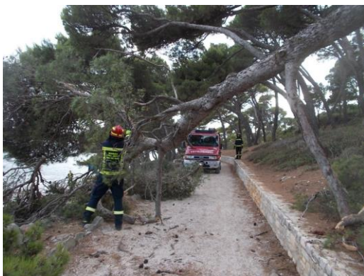
Sanacija posljedica nevremena
